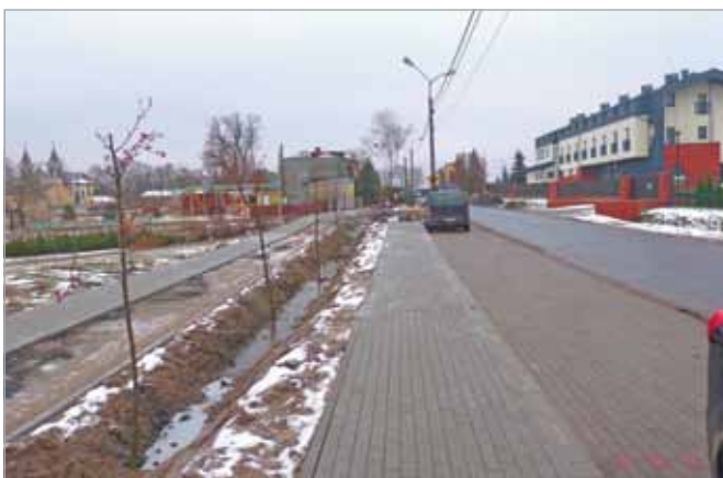
Zakończono prace budowlane przy Placu Chopina w Borzęcinie Dużym (chodnik, ścieżka rowerowa, miejsca parkingowe)
