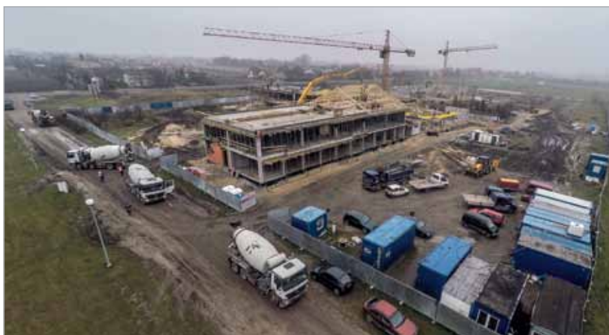
Nowy kompleks edukacyjno-kulturalno-sportowy w budowie
