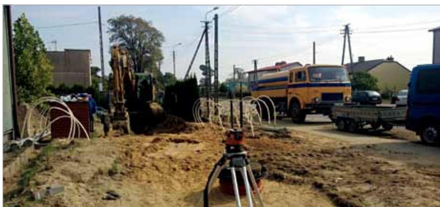
Prace przy budowie sieci kanalizacyjnej przy ul. Warszawskiej w Borzęcinie Dużym
