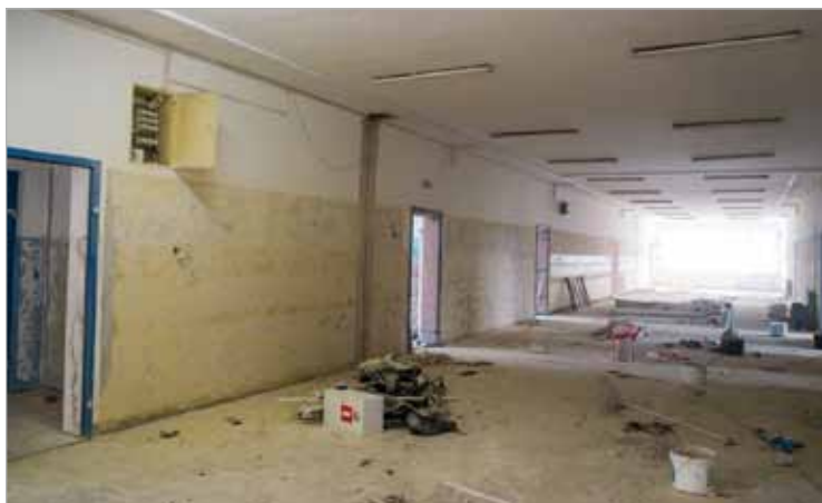
Remont II piętra w Sz.P. w Starych Babicach
