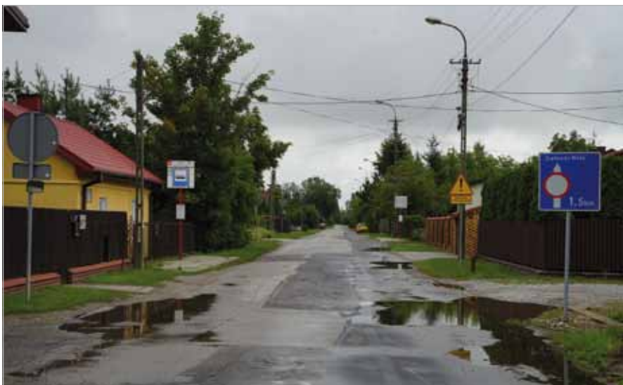
Ulica Jakubowicza przed remontem
