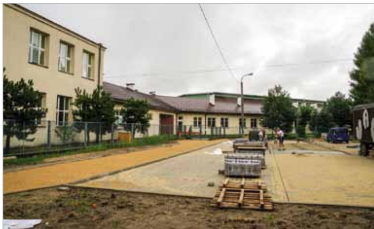
Przebudowa parkingu przed Zespołem Szkolno-Przedszkolnym w Borzęcinie Dużym
