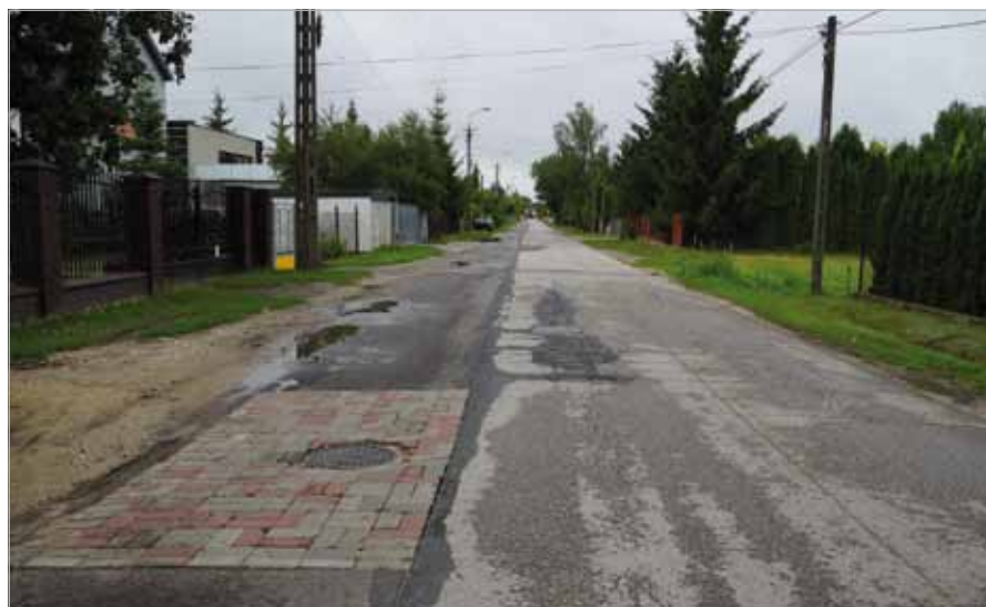
Ulica Jakubowicza przed remontem
