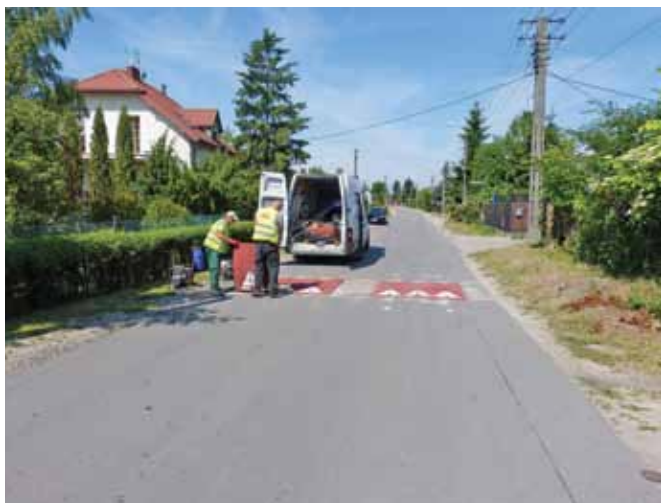
Zakończono montaż 9 progów wyspowych na Trakcie Królewskim w Wojcieszynie (fot. MZ)
