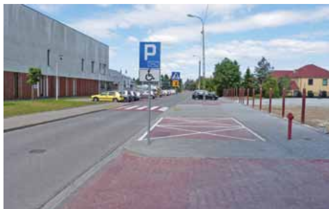
Zakończono prace związane z budową parkingu w Bliznem Jasińskiego (pomiędzy kościołem a przedszkolem) (fot. MZ)
