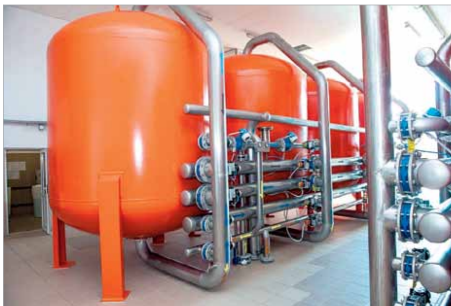
Automatyczna Stacja Uzdatniania Wody w Borzęcinie Małym
