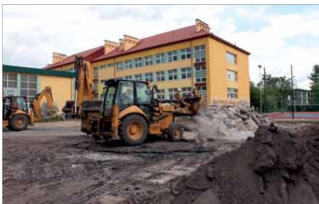
Budowa boisk ze sztuczną nawierzchnią przy szkole podstawowej w Starych Babicach
