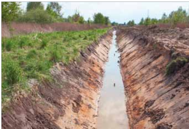
W Janowie powstaje rów odwadniający i rurociąg
