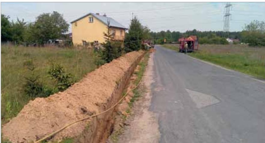
Prace przy kładzeniu światłowodu trwają
