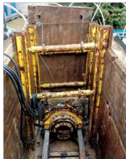
Prace kanalizacyjne przy ul. Warszawskiej w Koczargach Nowych
