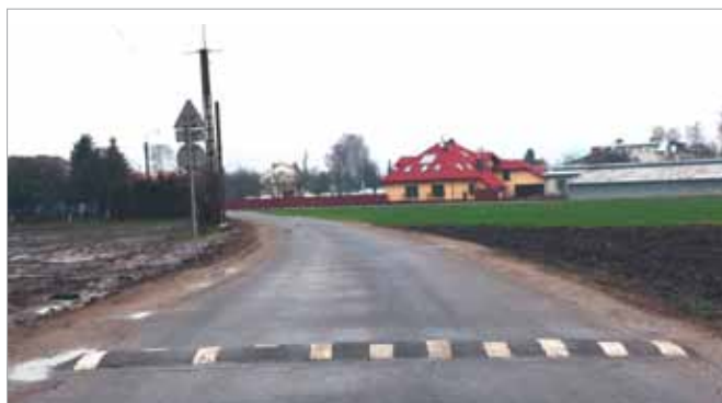
Nowa nawierzchnia na ul. Okrężnej. Wykonano tam ponad 1100 m nowego asfaltu
