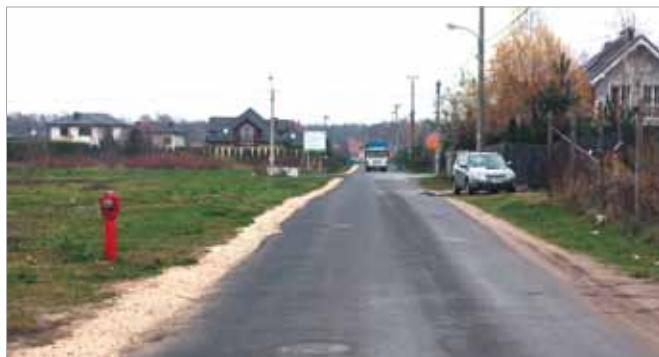
Na ul. Agawy wykonano tzw. odwodnienie francuskie. Rura drenarska została zasypana kruszywem w geowłókninie, dł. ok. 500 m
