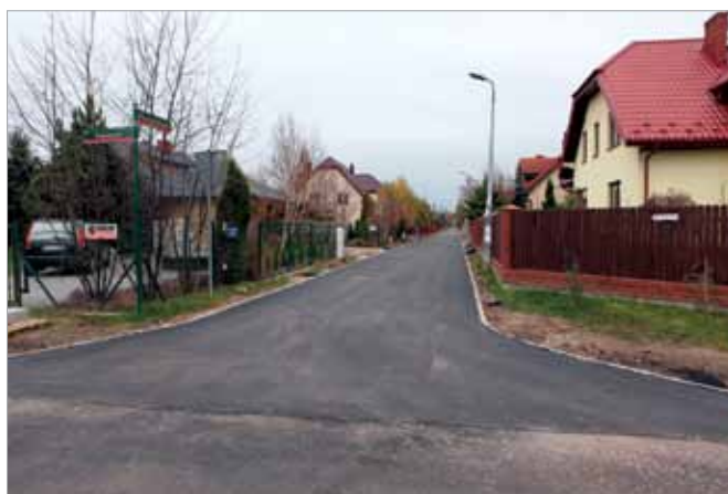
Na ul. Żurawie Mokradła w Kwirynowie po zakończeniu prac kanalizacyjnych wykonano nową podbudowę drogi i nową nawierzchnię, droga posiada odwodnienie nawierzchni, dł. 500 m
