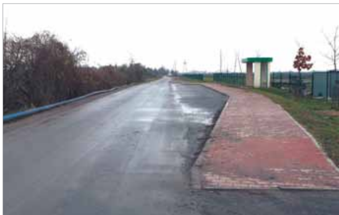
Na ul. Zachodniej w Zielonkach Parceli wykonano nową nakładkę asfaltową na długości 500 m wraz z zatoczką autobusową i poboczem
