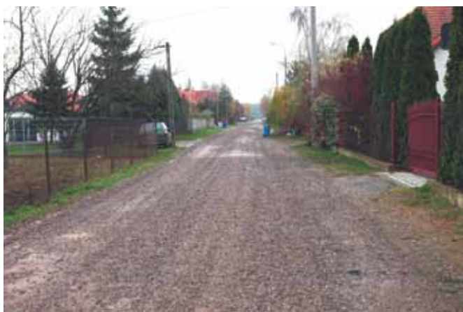
Żwirowe drogi konserwowane są w ramach całorocznych prac, żwir jest dosypywany i wyrównywany, ostatnio w ten sposób poprawiono nawierzchnie dróg m.in. w: Kwirynowie, Klaudynie i Borzęcinie. Na zdjęciu ul. Kalinowa w Kwirynowie
