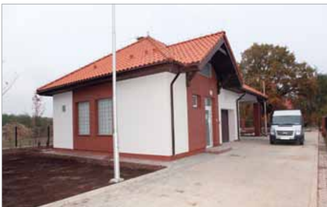
Przepompownia w Koczargach Starych
