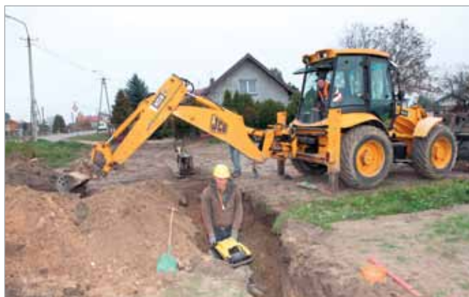
Prace kanalizacyjne przy ul. Warszawskiej
