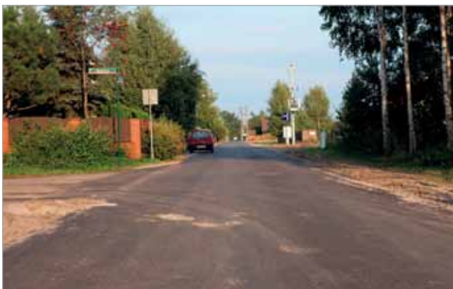
Na ul. Górki w Koczargach nowa nakładka asfaltowa położona została pomiędzy ulicami: Szkolną i Sosnową, długość nowej nawierzchni ok. 500 m
