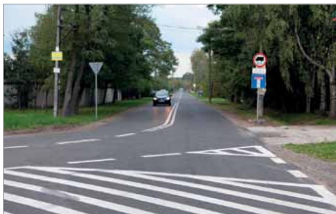
Na ul. Białej Góry w Zielonkach Wsi nakładkę asfaltową położono na dł. blisko 1500 m, poprawiono również rowy odwadniające
