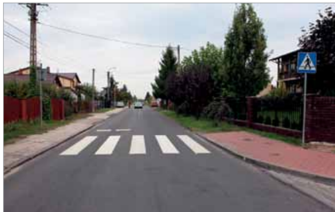
Na ul. Pohulanka w Starych Babicach na dł. 1200 m położono nową nakładkę asfaltową, aktualnie poprawiane są tam wjazdy na posesje i rowy odwadniające. Powstało także oznakowane przejście dla pieszych
