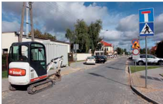
W Starych Babicach przed nowym budynkiem Urzędu Gminy wykonano drogę z kostki (ok. 300 m) i nowe miejsca parkingowe. Już wkrótce, gdy prace zostaną zakończone, będzie mogło zaparkować tam 60 samochodów. Nowy budynek uzyskał opaskę odwadniającą, instalacje odwadniające pojawiły się także na parkingu
