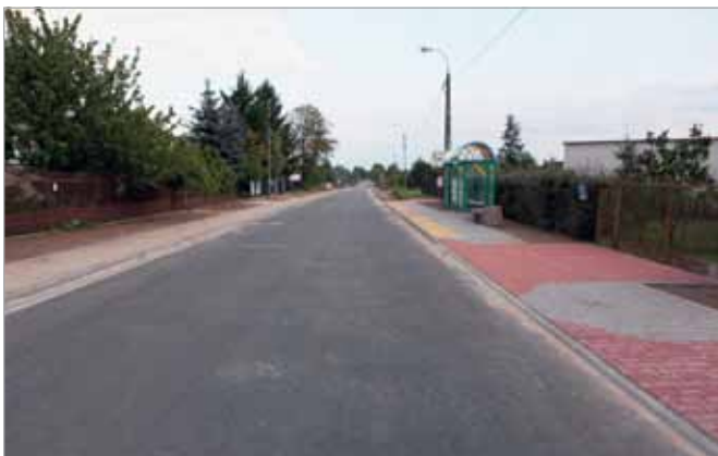
Na ul. Mościckiego – drodze powiatowej, przebudowa dobiega już końca. Drogowcy położyli tam ostatnią warstwę asfaltu. Aktualnie trwają prace wykończeniowe przy wjazdach do posesji i chodnikach. Prace zostaną tam sfinalizowane prawdopodobnie pod koniec września. Przypominamy, że inwestycja na ul. Mościckiego finansowana jest z trzech źródeł: 50% z budżetu państwa – z Narodowego Programu Budowy Dróg Lokalnych (z tzw. schetynówki), a pozostałe 50%, po połowie, finansują PWZ i Gmina Stare Babice
