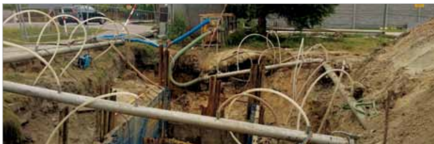
Odwadnianie wykopu przy pomocy igłofiltrów przy ul. Warszawskiej w Wojcieszynie
