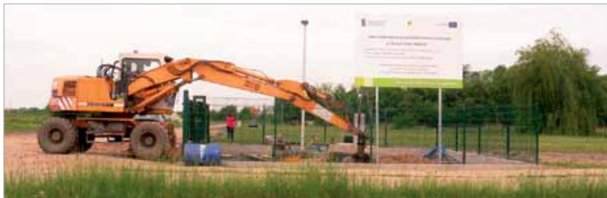
Prace przy budowie przepompowni ścieków przy ul. Południowej w Zielonkach Parceli
