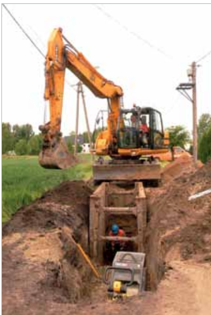
Prace przy ul. Wiosennej w Bugaju
