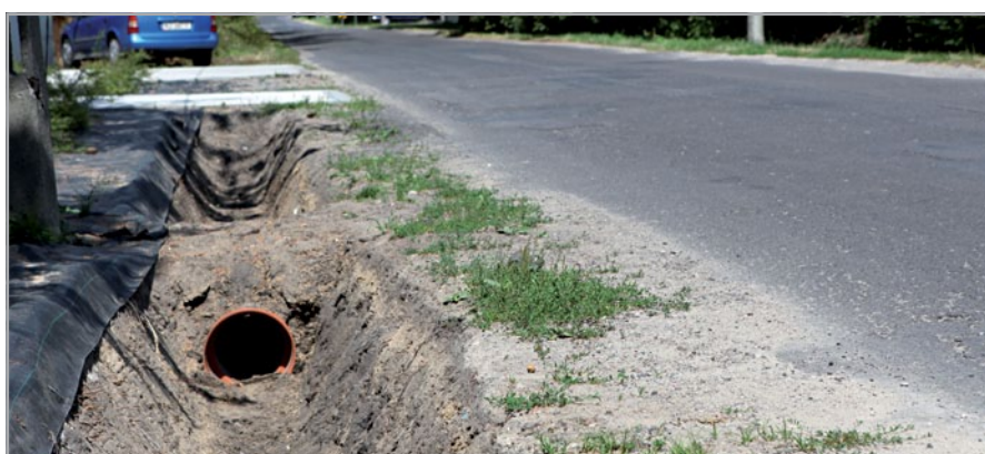
Rowy odwadniające przy ul. Białej Góry
