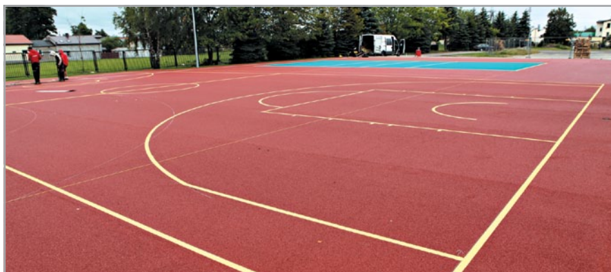
Kolejny etap budowy wielofunkcyjnego boiska w Starych Babicach
