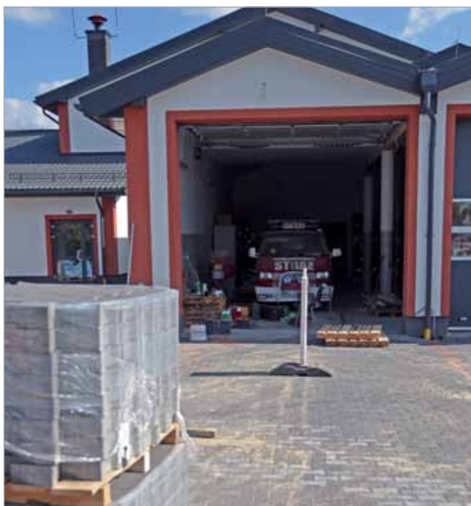
Kończy się budowa strażnicy OSP w Babicach Nowych (podjazd, wnętrze strażnicy).
