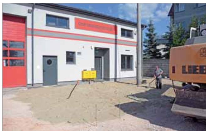
Rozbudowa strażnicy OSP w Borzęcinie Dużym w toku. Przebudowany jest podjazd, wykonywana jest elewacja budynku oraz system odprowadzania wody z rynien.
