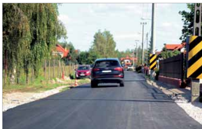
Wykonano już utwardzenie nawierzchni na ul. Kontuszowej w Lipkowie, modernizowane jest pobocze.
