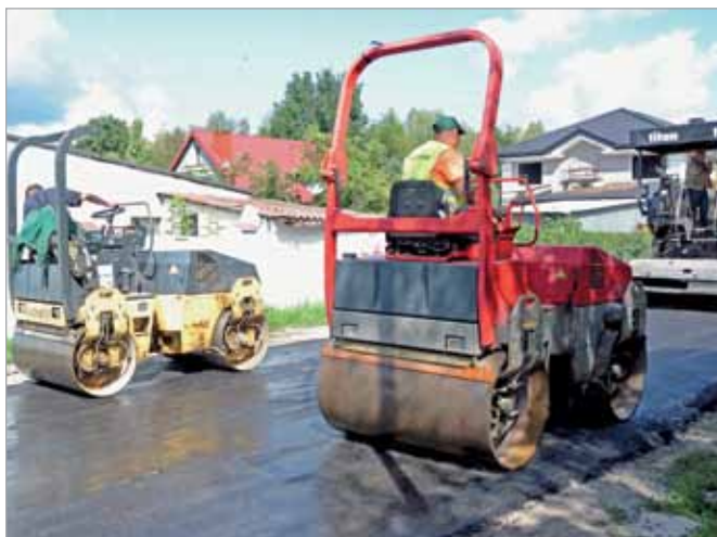
Zakończono utwardzanie nawierzchni ulic: Brahmśa, Wieniawskiego, Góreckiego oraz Kiepyry w Klaudynie.
