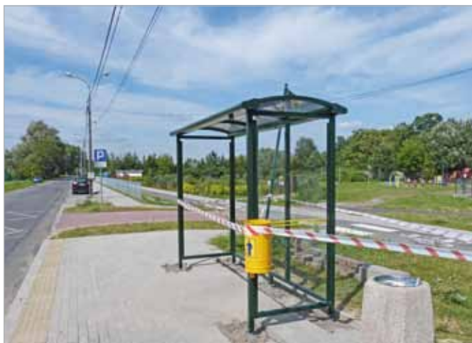
Wybudowano wiatę przystankową przy Placu Chopina w Borzęcinie Dużym
