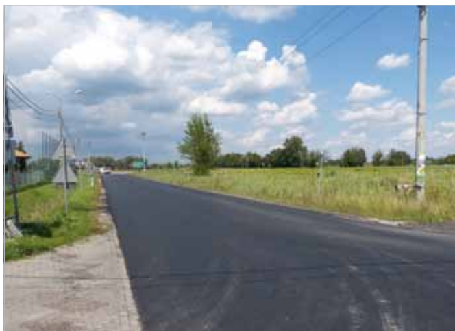
Trwa remont ulicy Sobieskiego w Borzęcinie Dużym (DW721)
