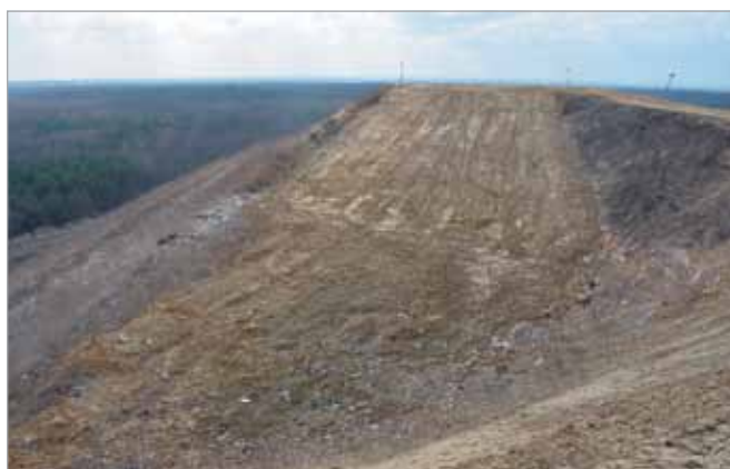
Tak wygląda początek przyszłej trasy zjazdowej
