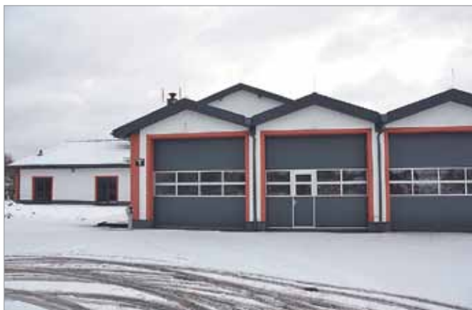
Zakończono budowę budynku nowej remizy OSP w Starych Babicach przy ul. Wieruchowskiej 5
