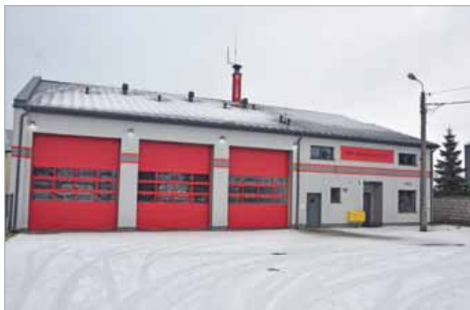
Zakończono rozbudowę budynku remizy ze świetlicą w OSP w Borzęcinie Dużym
