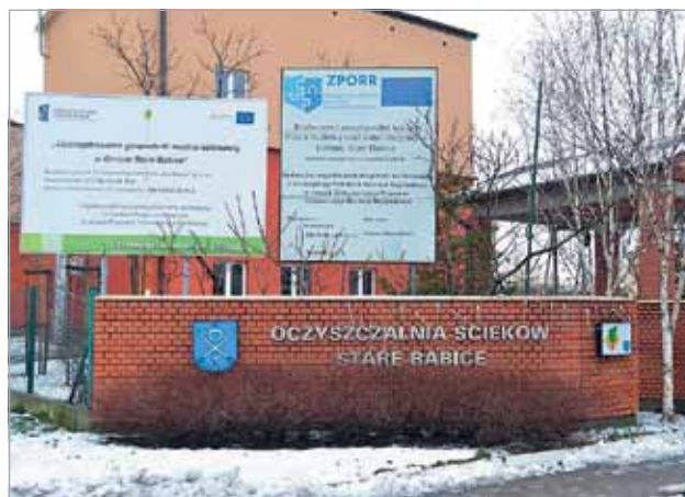
Zakończenie największego projektu inwestycyjnego w historii gminy pn. „Uporządkowanie gospodarki wodno-ściekowej w Gminie Stare Babice”
