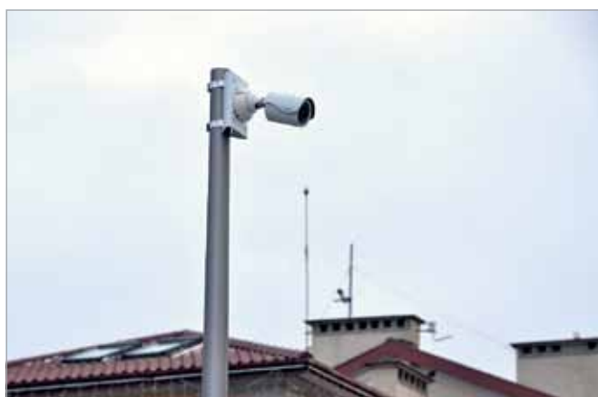
Zakończono realizację 1. etapu budowy sieci monitoringu na terenie gminy
