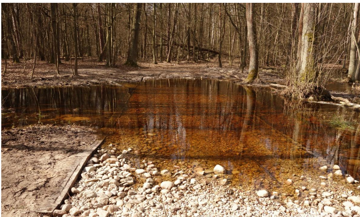
Bród z funkcją piętrzenia na obszarze Wilcza Struga. Budowla ta ma zatrzymywać niskie stany wody, natomiast w okresie wysokich stanów przepływ ma się odbywać swobodnie. luty 2017, fot. A. Andrzejewska
