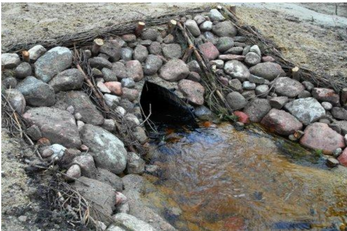
Jeden z wykonanych przepustów. Przez przepusty wykonane w ramach projektu woda ma przepływać jedynie w czasie wysokich poziomów wód w zlewni bezpośredniej danego cieku. sierpień 2017, fot. B. Grzebulska
